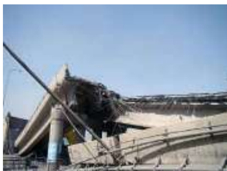
Рис. 1. Повреждения, обнаруженные на автомобильных мостах после землетрясения в Мауле в 2010 году (Чили)
